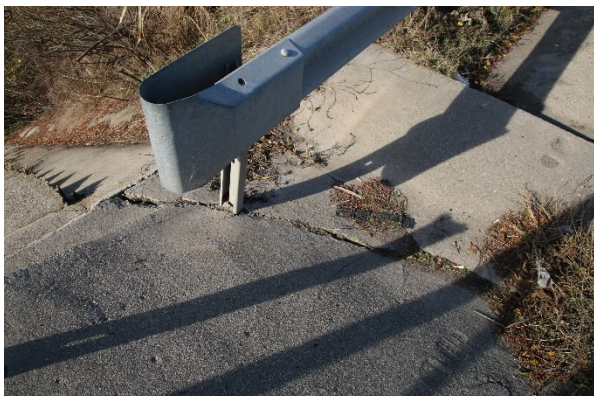
Fotografia 25. Detaliu racordare trotuar acostament: prezenta depozitelor de praf si vegetație pe acostament.
