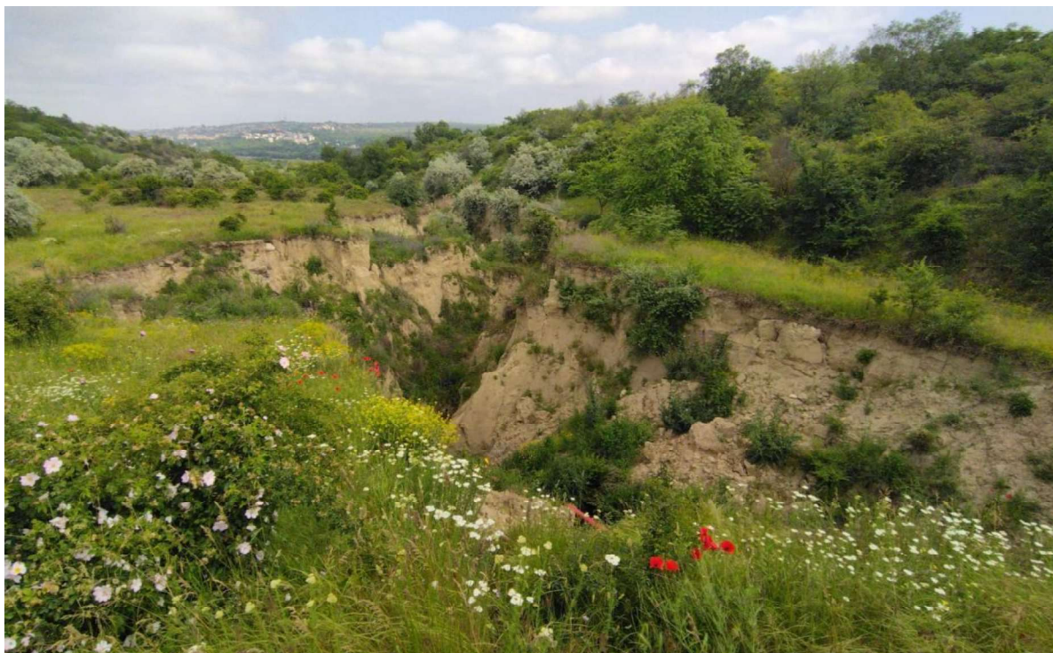
Foto 1. Zona de rupere/alunecare a terenului
