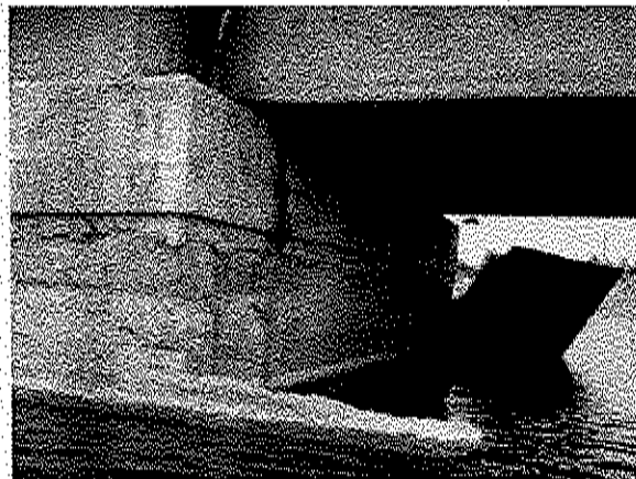
➤ Pila P5 (fosta culee a podului vechi), cu elemente de beton (foste ziduri intoarse) nedemolate
