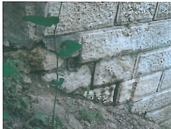
➤ Pereu degradat la sferturile de con si scari de acces din zidarie de piatra
