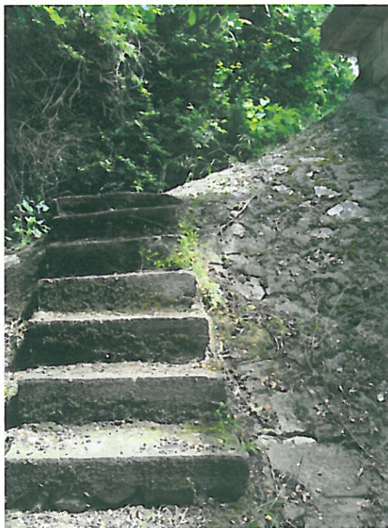
➤ Pereu degradat la sferturile de con si scari de acces din zidarie de piatra
