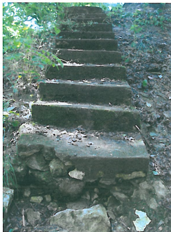
➤ Pereu degradat la sferturile de con si scari de acces din zidarie de piatra
