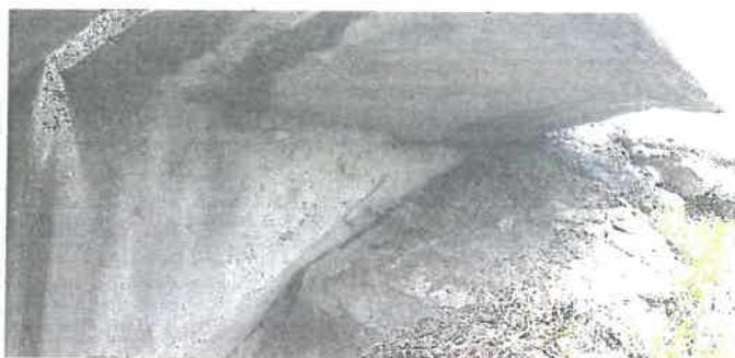
Aparatele de reazem sunt ruginite și pline cu murdarie iar bancheta de rezemare este încărcată cu deșeururi și asfalt.
