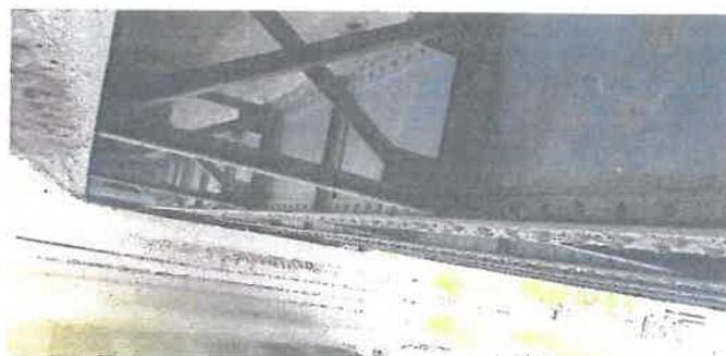
Zidurile întoarse și consolele de trotuar de pe acestea prezintă infiltrații și prelingeri de apă și zone cu beton degradat. Sferturile de con sunt degradate și sunt dislocate suprafețe de pereu.
